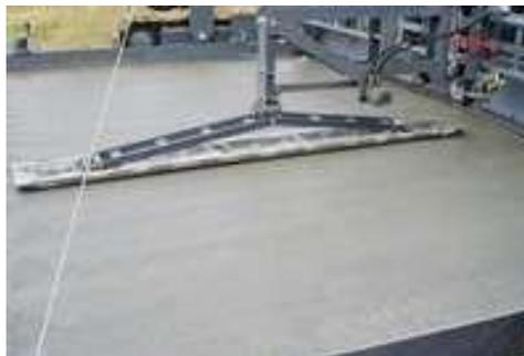
**Gambar 3.13 Pemadatan Material Beton**
